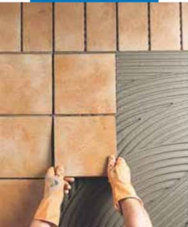
Укладка клинкерной плитки снаружи помещений
