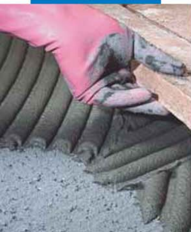
Укладка терракоты на неровное основание
