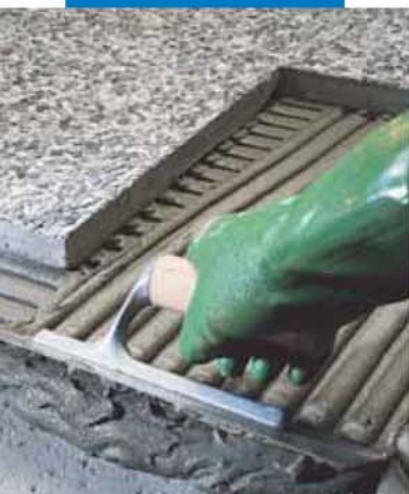
Укладка плитки терракко с рельефной поверхностью снаружи помещений
